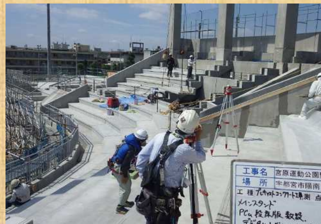
機械読み取り式デジタルレベルによる確認
