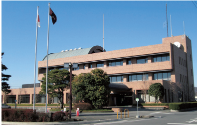
▲民俗資料館の移設予定先である上河内地域自治センター（現在改修中）
