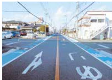
▲自転車走行空間が整備された道路
