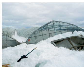
▲大雪で倒壊したビニールハウス
