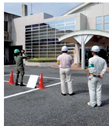
▲赤外線サーモグラフィを使用した調査の様子
