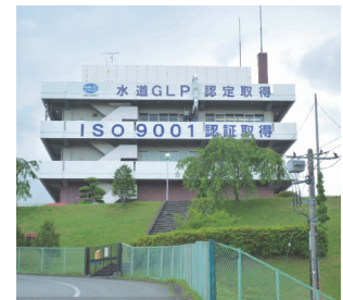
▲松田新田浄水場
