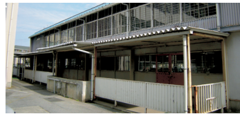
▲石井小学校屋内運動場（工事前）
