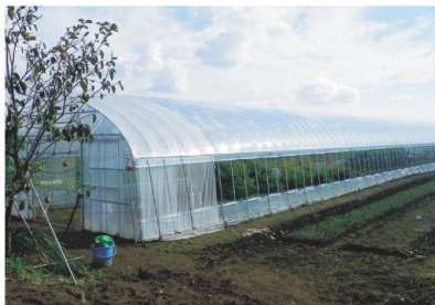
▲園芸作物生産施設等整備事業で建てられたビニールハウス
