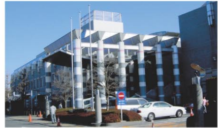
▲駅東出張所が移転する東図書館・東市民活動センター
