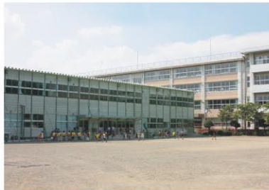
▲完成した清原中央小の仮設校舎
