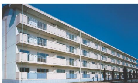
▲山王市営住宅
