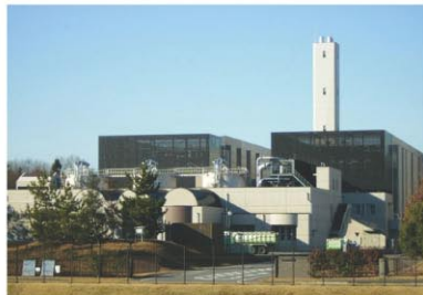
▲県下水道資源化工場
