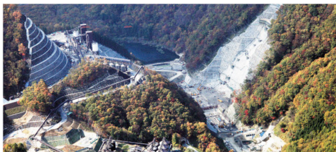
▲建設中の湯西川ダム 写真は、湯西川ダム工事事務所提供 (鹿島・清水JV撮影)
