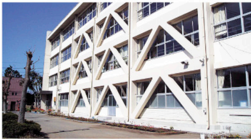
▲耐震補強工事を実施した校舎
