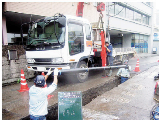
▲水道管の取り替え工事の様子
