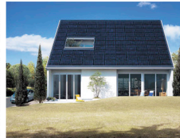
▲太陽光発電システムを設置した住宅
