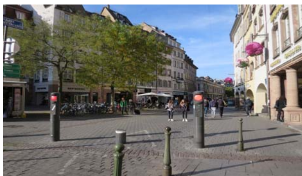
車の進入を禁止するためのボラード
