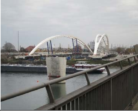
ドイツとの国境の川に橋を架け LRTで結ぶ工事現場
