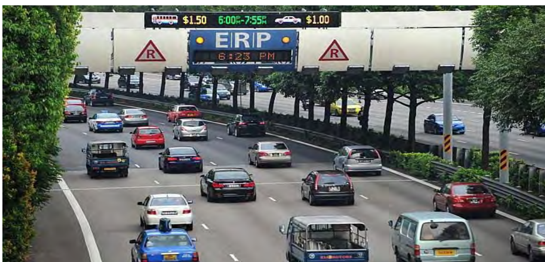
ERPシステム (Electronic Road Pricing : 道路通行料電子課金システム)
