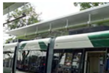
全線架線レスのため蓄電装置 キャパシターで充電
