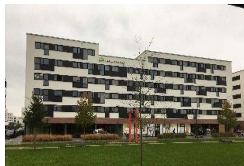
高気密高断熱仕様のオフィスビル
