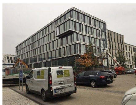
近代的開発地区では、現在も大規模な工事が進められている
