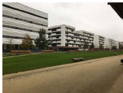
中心市街地では外装にブラインドを設け、採光と断熱性能の向上を図るバーンシュタット地区
