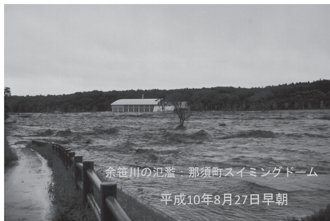
写真1 「余笹川氾濫写真」
