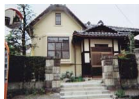
写真 21 大寛町に残る築80年の洋館（修繕後）
