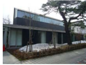
写真 14 旧本丸内に建築された時代小説家 藤沢周平記念館 (平成22年4月29日開館予定)
