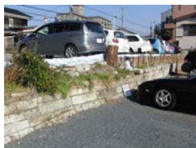
写真8 擁壁として残る南館堀の痕跡
