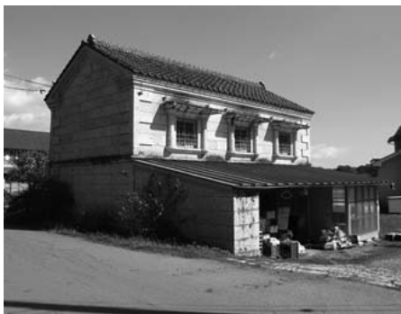
図 21 既存大谷石建物
