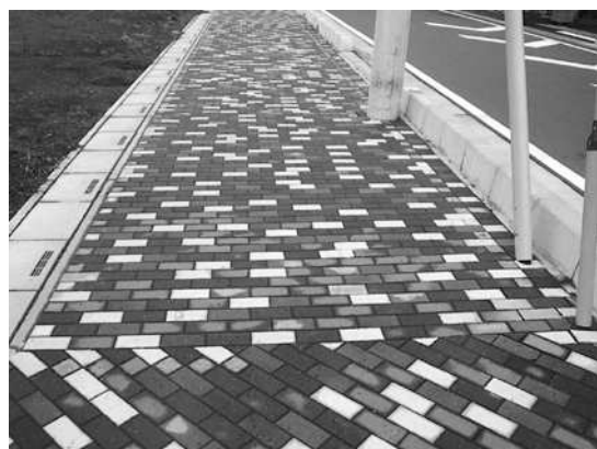
写真8 インターロッキングによるカラー舗装
