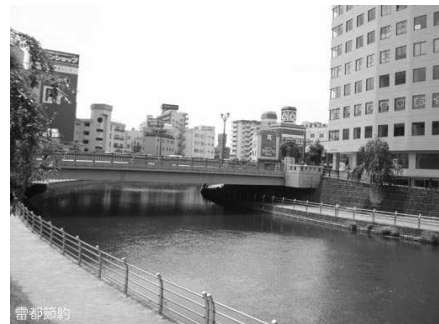
写真7 田川沿いの歩道
