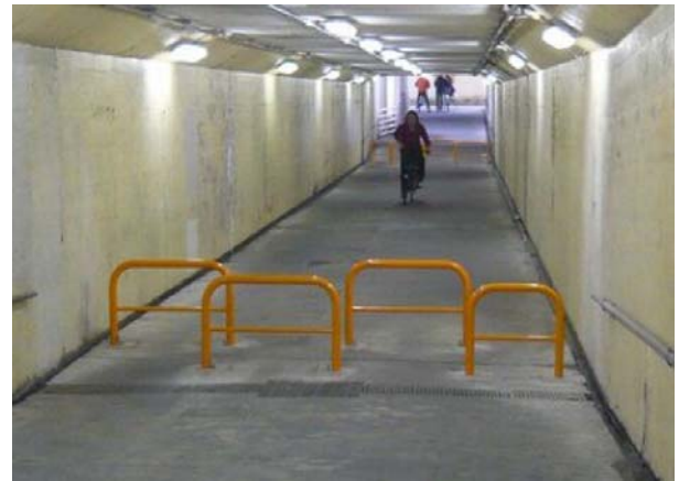
図9 新設された車止め
