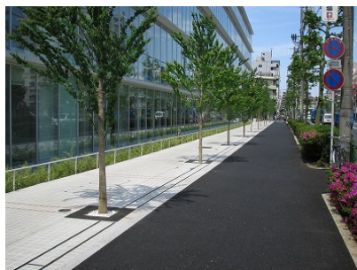
セットバックにより整備された歩道状空地
