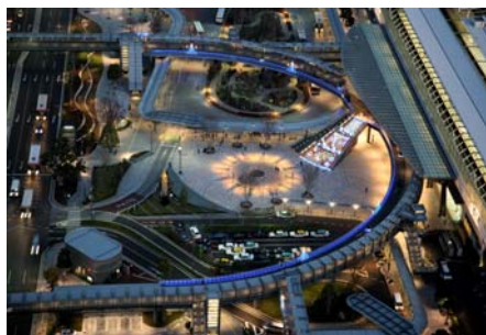
豊かな歩行者空間を確保し再整備された駅前広場
