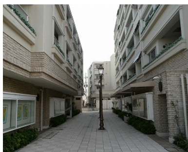
共同化により更新された住宅と通り抜け通路
