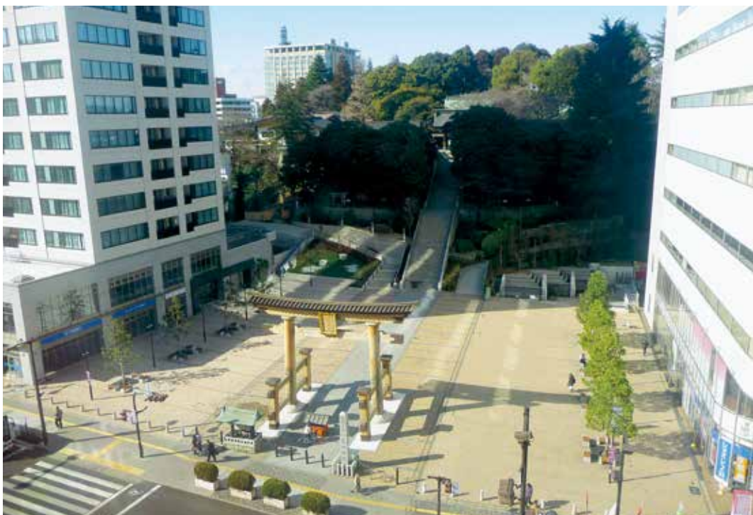
地区計画により位置付けた拠点広場
