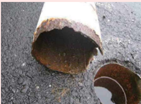
ポールの根腐れによる倒壊
