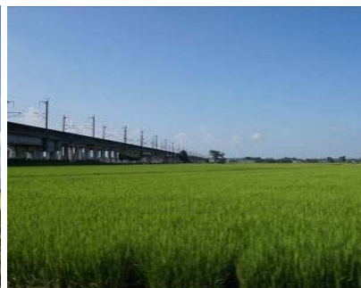
<新幹線の高架橋と田園風景>
