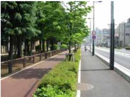
路側帯のカラー化による自転車通行帯の明確化（埼玉県川口市）
