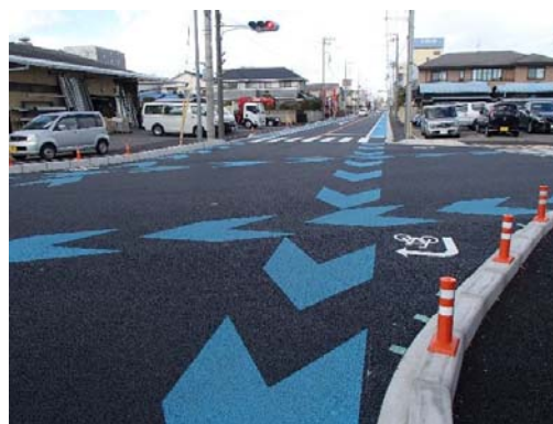
写真 交差点部における矢羽根(宮の原通り)
