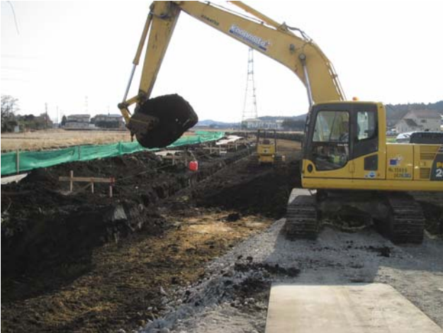
③北側・消防学校付近（平成 2 4 年 3 月末現在）
