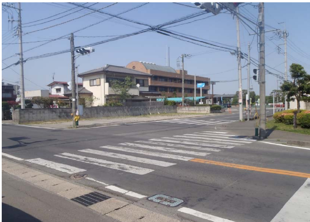
市道10111号線（一部未完了）
