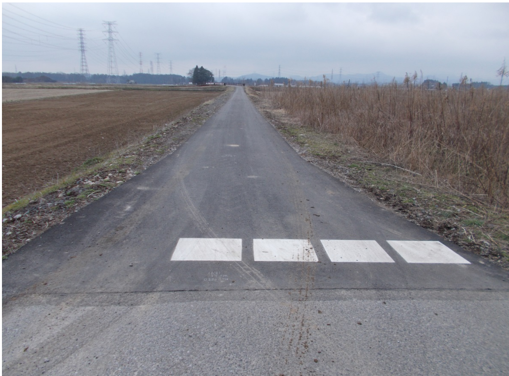
西鬼怒川東側境橋付近
