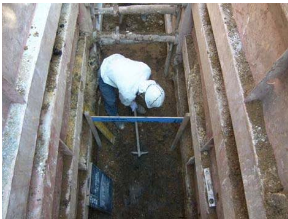
掘削状況 (床均し)
