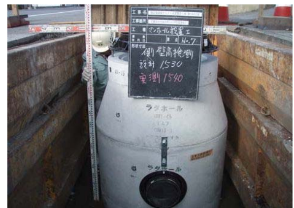
マンホール設置
