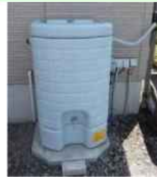
宅地内の雨水貯留タンク
