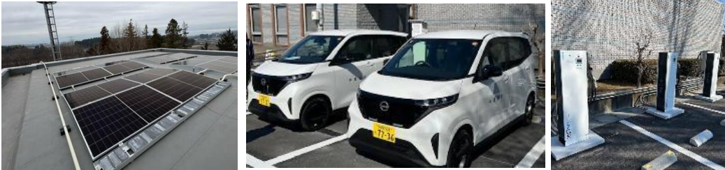
▼EV車・EV充放電器 (東市民活動センター) ※R6設置導入
