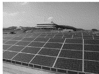
松田新田浄水場
