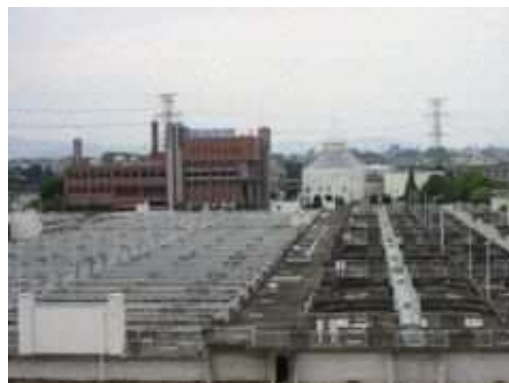
(写真：川田水再生センター)
