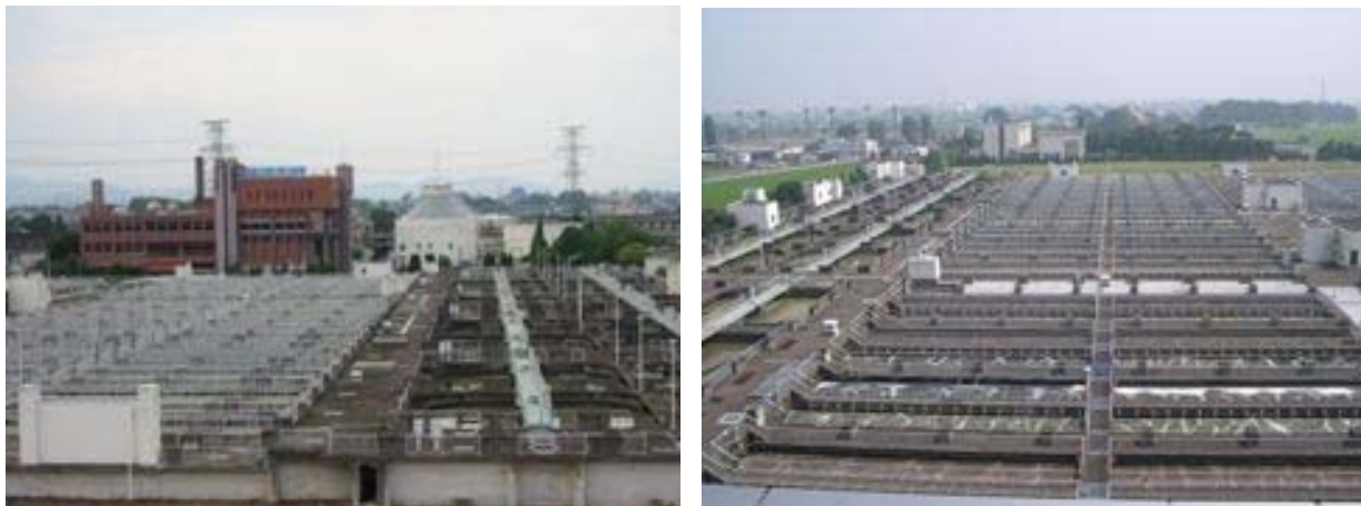
(川田水再生センター)
