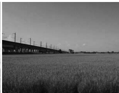
<新幹線の高架橋と田園風景>
