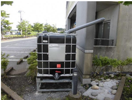
図 3.7 公共施設での貯留タンク設置
