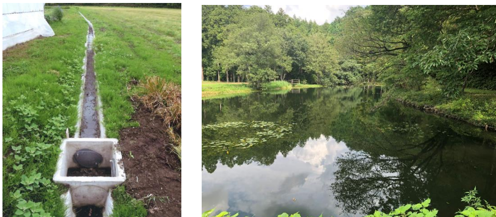
図 3.12 改修された水路の様子・唐沢溜
