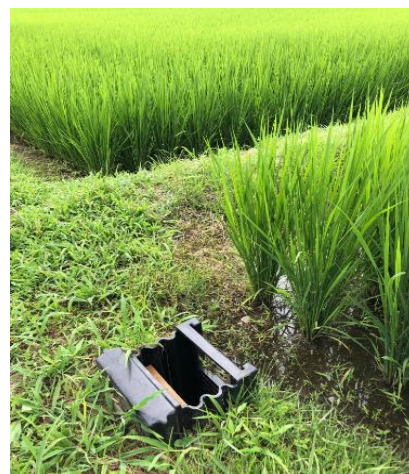
水田に設置された排水調整マス
