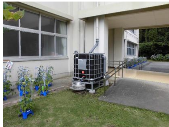
図 3.7 公共施設での貯留タンク設置
