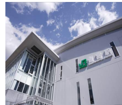
⑮雀宮橋上駅舎整備
