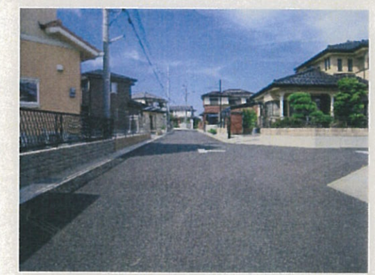
②宇大東南部第1土地区画整理事業地内 区画道路(2)
