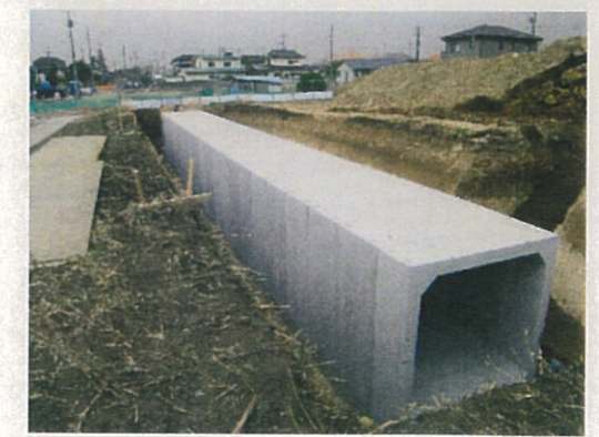
④雨水貯留管整備事業
