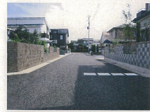
①宇大東南部第1土地区画整理事業地内 区画道路(1)
