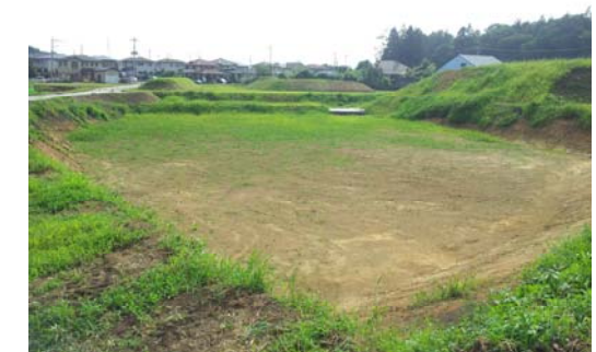
④調整池整備
