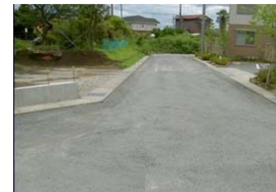
土地区画整理事業地内 ③区画道路整備
