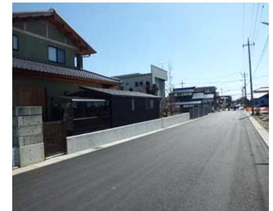
土地区画整理事業地内 ②区画道路整備
