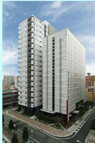
施設全景北東側より
