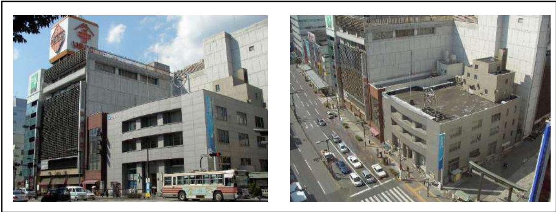
従前(再開発前)の状況
