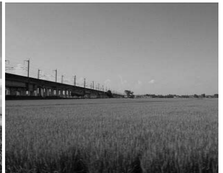
<新幹線の高架橋と田園風景>
