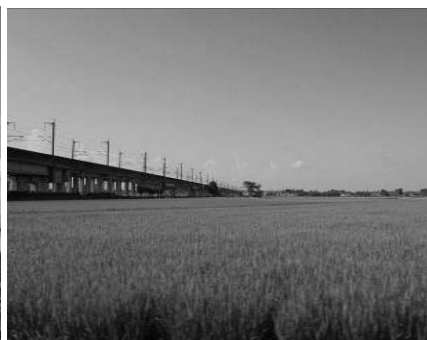
<新幹線の高架橋と田園風景>
