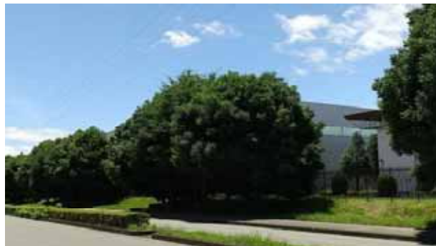
工場敷地内周辺部への立木の設置状況
