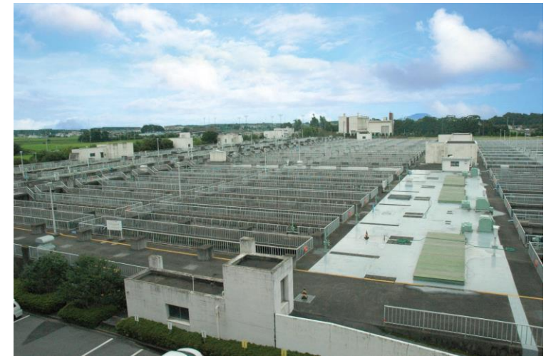
川田水再生センター
