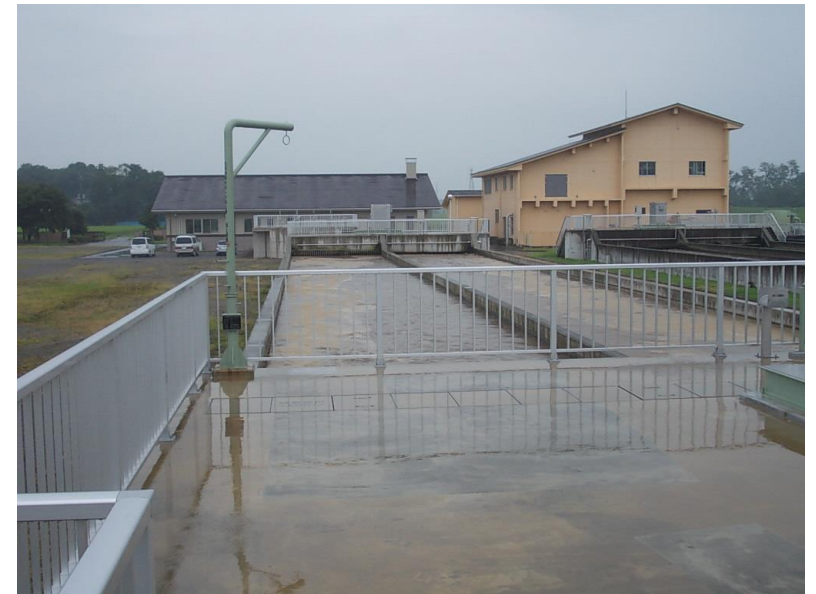
河内水再生センター
