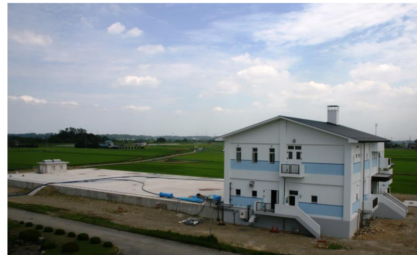
白沢浄水場（平成22年度全面改築）
