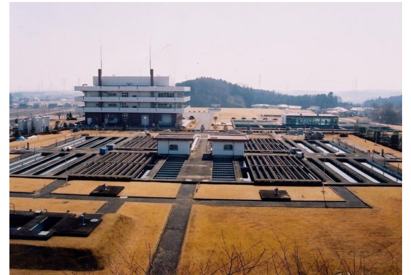
松田新田浄水場
