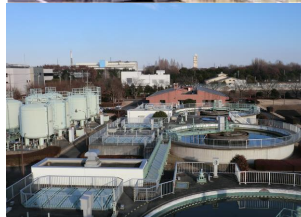
清原工業 団地排水 処理施設
