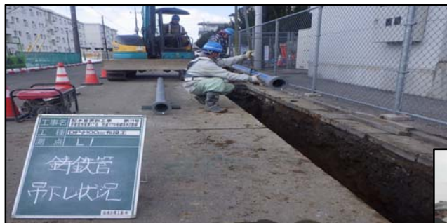
新しい管の布設
