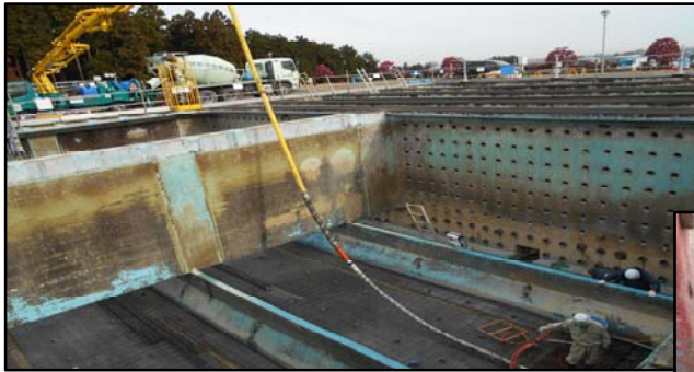
松田新田浄水場沈澱池
