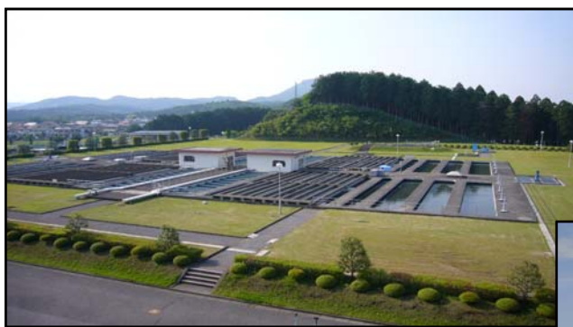
松田新田浄水場
