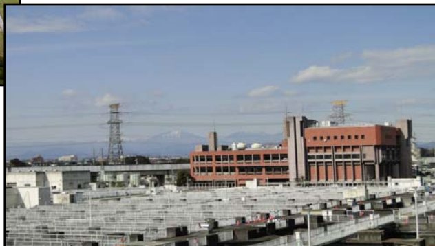
川田水再生センター
