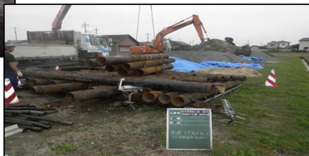
撤去した老朽管
